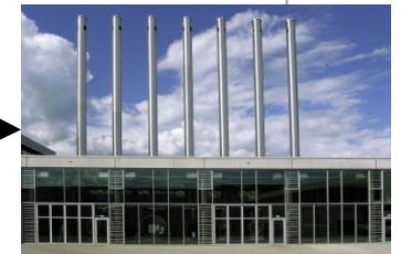
Energiezentrale Werk I
