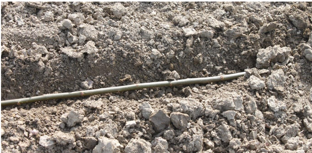
Obrázek 35: Horizontálně položený vrbový prýt, který musí být ještě zasypan zeminou. (Zdroj: Rutz D.)
