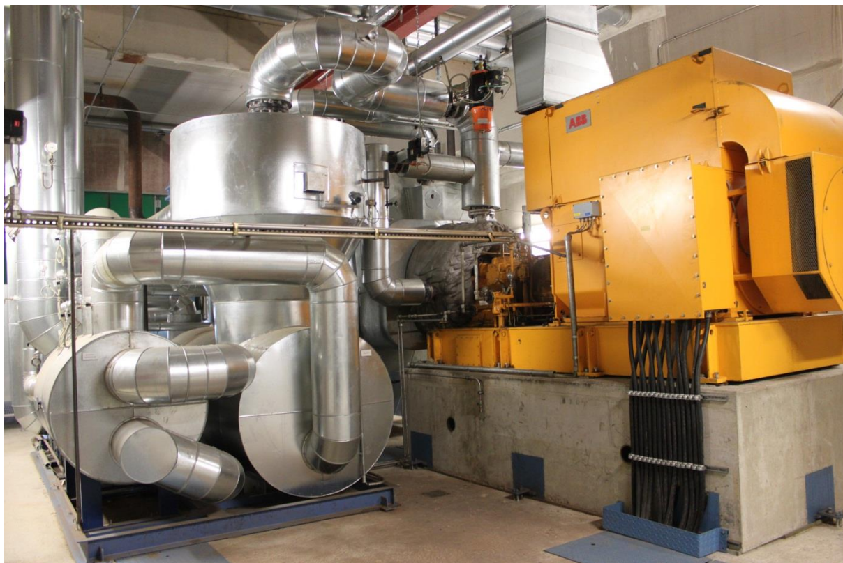
Obrázek 63: ORC systém (1520 kW el ) v Grünfütterungstrocknungsgenossenschaft Kirchdorf a.H. eG, Německo. (Zdroj: Rutz D.)
