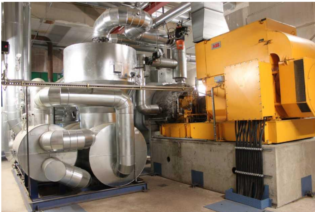
63.attēls: ORC sistēma (1,520 kW el ), Grunfüttertrocknungsgenossenschaft Kirchdorf a.H. eG Vācijā (Avots: Rutz D.)
