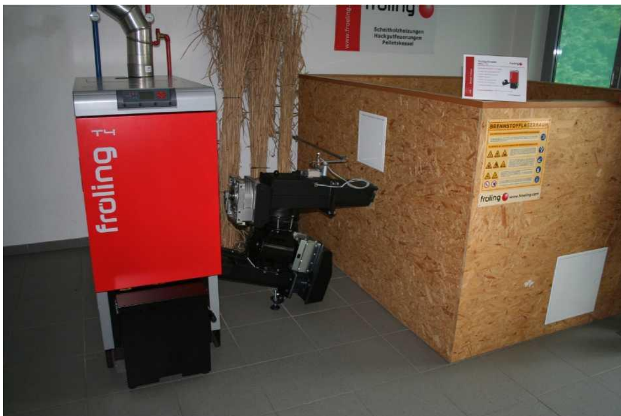
61.attēls: Neliela Fröling šķeldas apkures sistēma (24-50 kW jauda) ar apkures katlu (pa kreisi), kurināmā padeves sistēmu (vidū) un šķeldas uzglabāšanas tvertni (pa labi) (Avots: Rutz D.)
