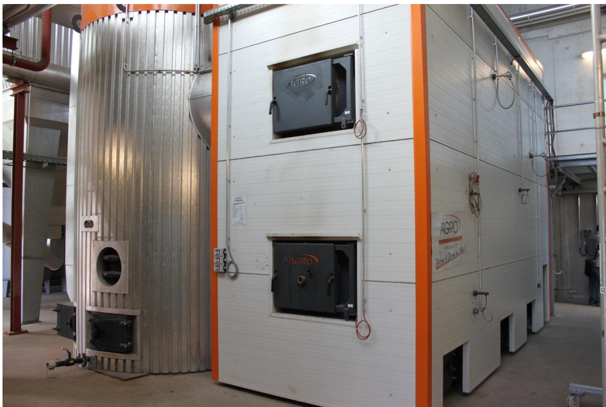
Слика 62: Средна големина на систем за греење со дрвен чипс (3,000 kW греен капацитет) со котел (десно) и резервоар (лево) во центарот за биомаса, Ахентал, Германија (Source: Rutz D.)
