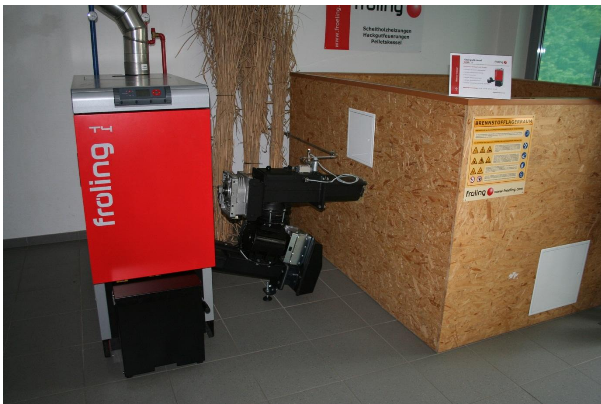
Слика 61: Мал систем за греење со дрвен чипс (24-50 kW греев капацитет) со котел (лево), систем за дотур (средина) и склад за дрвен чипс (десно), производител Fröling (Source: Rutz D.)
