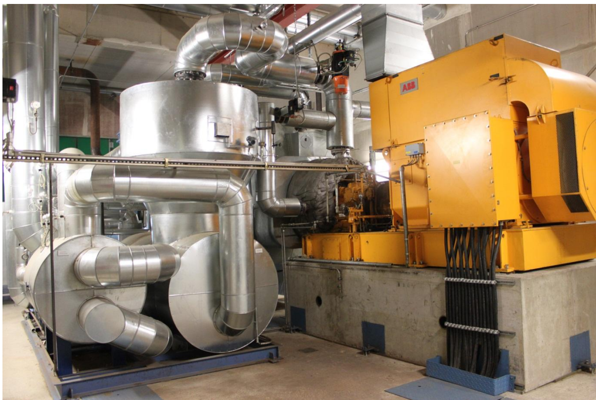
Слика 63: ORC систем (1,520 kWel) (Grünfütterertrocknungsgenossenschaft Kirchdorf a.H. eG) во Германија (Source: Rutz D.)
