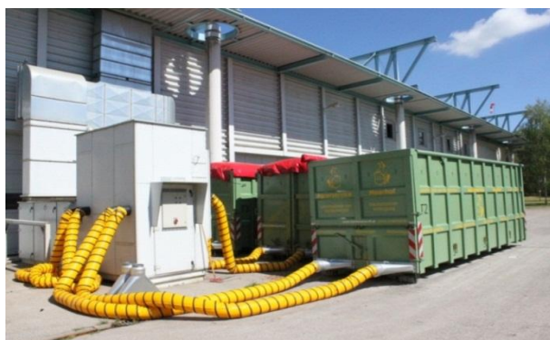
Слика 47: Контејнер со цевки за топол воздух во централа за биогаз во Минхен, Германија. (Извор: Rutz D.)
