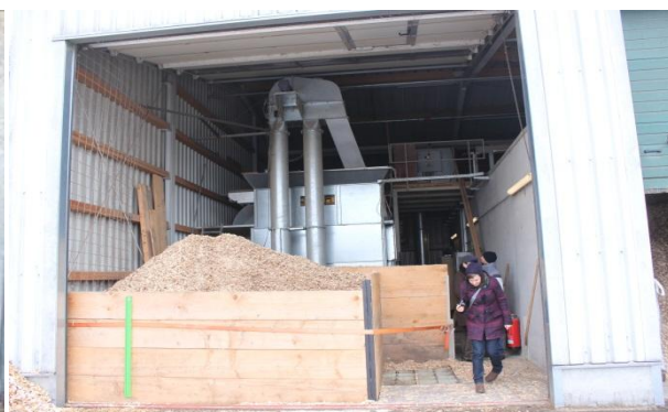
Слика 50: Сушална со мешање инсталирана во централа на биогаз во Германија (Извор: Rutz D.).
