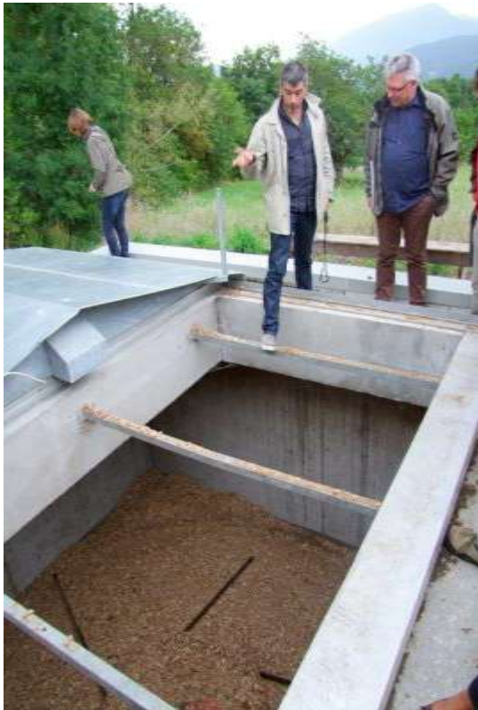
Abbildung 6: Besuch einer Hackschnitzelheizung (versorgt städtische Gebäude, die Bibliothek und 3 gemeinde eigene Wohnungen mit Wärme) in Le Percy (Frankreich)
