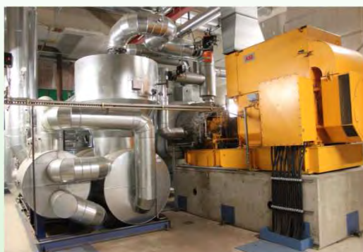
ORC sustav nazivne električne snage 1 520 kW
