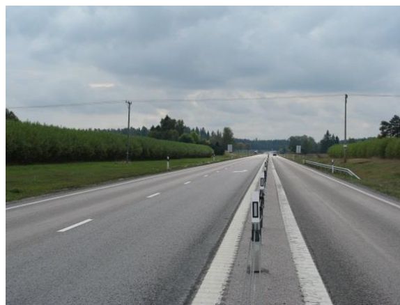
Figure 24: Les champs de TCR proche des grandes routes doivent être pourvus de grandes bordures pour laisser de la visibilité aux conducteurs. (Photo: Nils-Erik Nordh)
