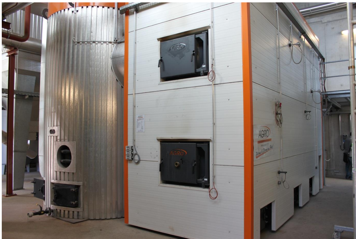
Obrázek 63: Středně velký kotel na štěpku (výkon 3 000 kW) (vpravo) a zásobník (vlevo) v biomasovém centru Achental, Německo. (Zdroj: Rutz D.)
