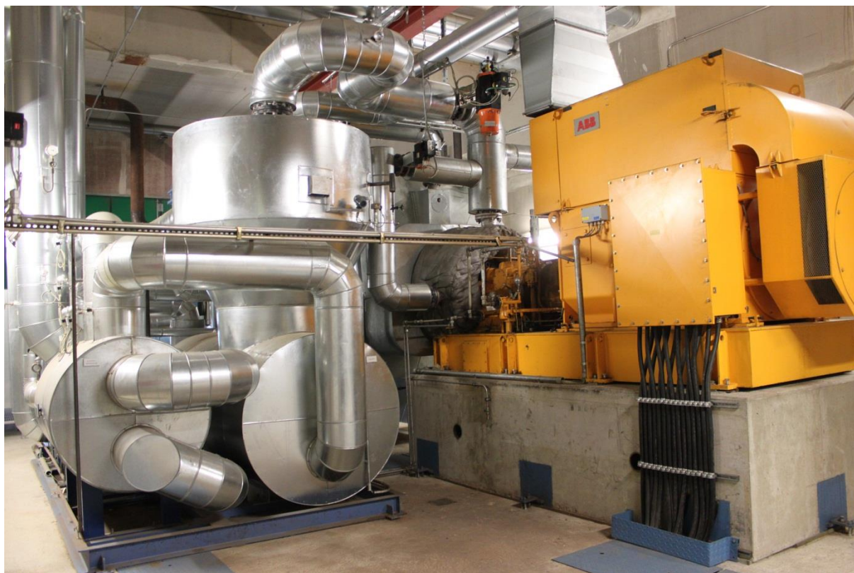
Obrázek 64: ORC systém (1520 kW el ) v Grünfüttertrocknungsgenossenschaft Kirchdorf a.H. v Německu (Zdroj: Rutz D.)
