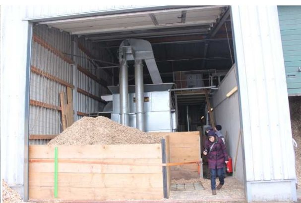
Slika 50. Transportno-zakretna sušilica za drvenu sječku postavljena na bioplinskom postrojenju u Njemačkoj (Izvor: Rutz D.).
