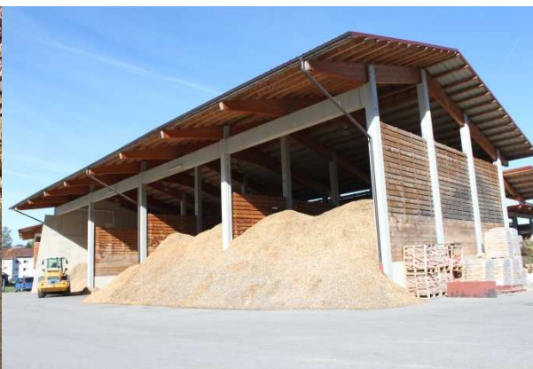
Slika 52. Idealni objekt za skladištenje drvene sječke u centru za trgovanje biomasom Biomass Trade Centre Achental u Njemačkoj (Izvor: Rutz D.).
