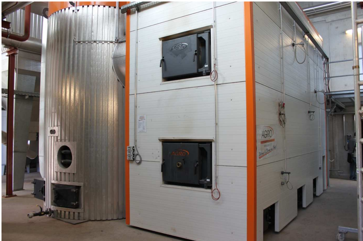
Slika 62. Sustav grijanja na drvnu sječku srednje veličine (kapacitet grijanja od 3 000 kW) s kotlom (desno) i spremištem topline (lijevo) od društva Biomassehof Achental u Njemačkoj (Izvor: Rutz D.)
