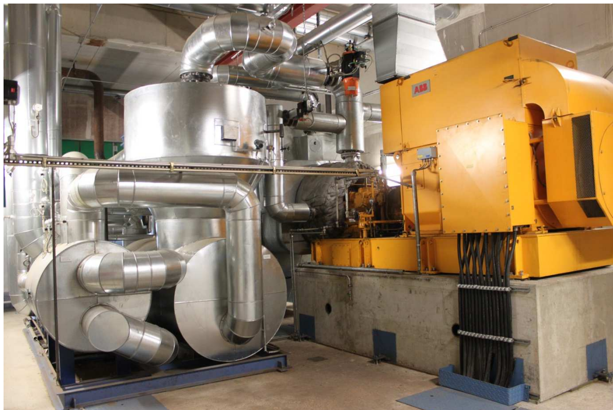
Slika 63. ORC sustav (1,520 kWel) poduzeća Grünfüttertrocknungsgenossenschaft Kirchdorf a.H. eG u Njemačkoj (Izvor: Rutz D.)
