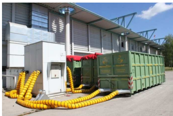
Slika 47. Kontejner i cijevi za grijanje zrakom za drvenu sječku koja se suši u bioplinskom postrojenju u Münchenu, Njemačka (Izvor: Rutz D.).
