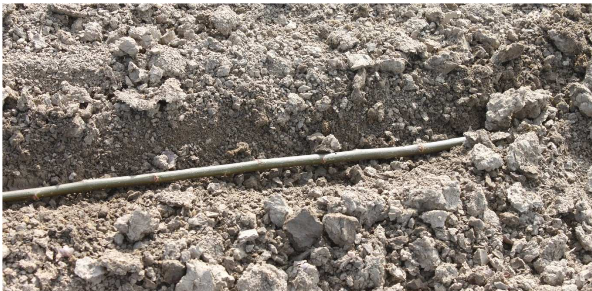
Slika 34. Horizontalno položen prut vrbe: prut još treba pokriti zemljom (Izvor: Rutz D.)
