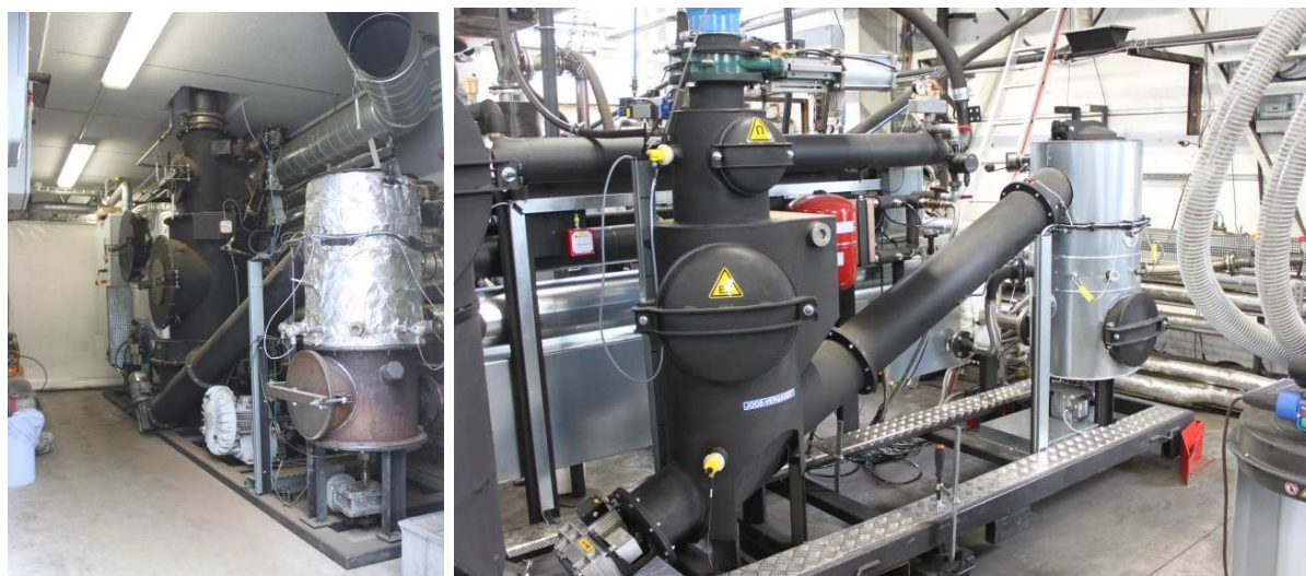
Slika 59. Mali rasplinjači u kontejneru (lijevo) i tijekom proizvodnih procesa (desno) u poduzeću „SpannerRE” (Izvor: Rutz D.)
