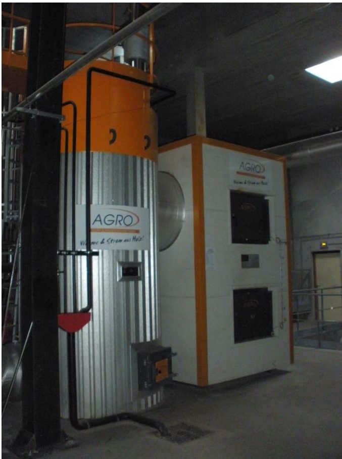
Photo 62: Chaudière à plaquette de forte puissance (2,000 kW) la chaudière (droite) le traitement des fumées (gauche) – CIDERAL à Loudéac (Source: Aile).
