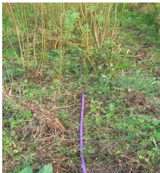
Photo 77 : Tuyau Bioline irrigant en gouttes à gouttes les eaux prétraitées en provenance de la station d'épuration (Source Aile).
