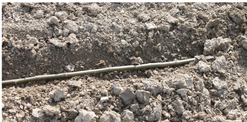
Photo 34: Tige de saule plantée horizontalement : elle doit être recouverte de terre (Source: Rutz D.)
