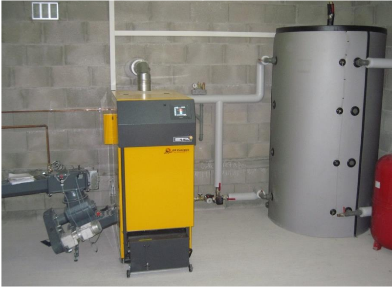
Photo 61: Chauffage d'un petit élevage de porcs. Chaudière à plaquettes ETA (70 kW) équipée d'un bac à cendres, le système d'alimentation par vis et le stockage de plaquettes (à gauche), un ballon tampon (à droite) (Source : Aile).
