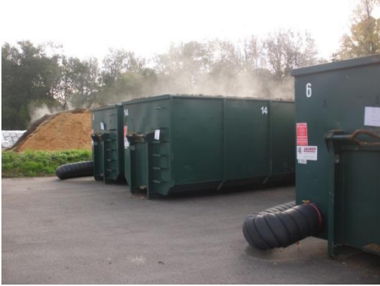
Photo 47 Séchage en caisson amplyroll avec l'air chaud issu de la cogénération (Source:Aile).
