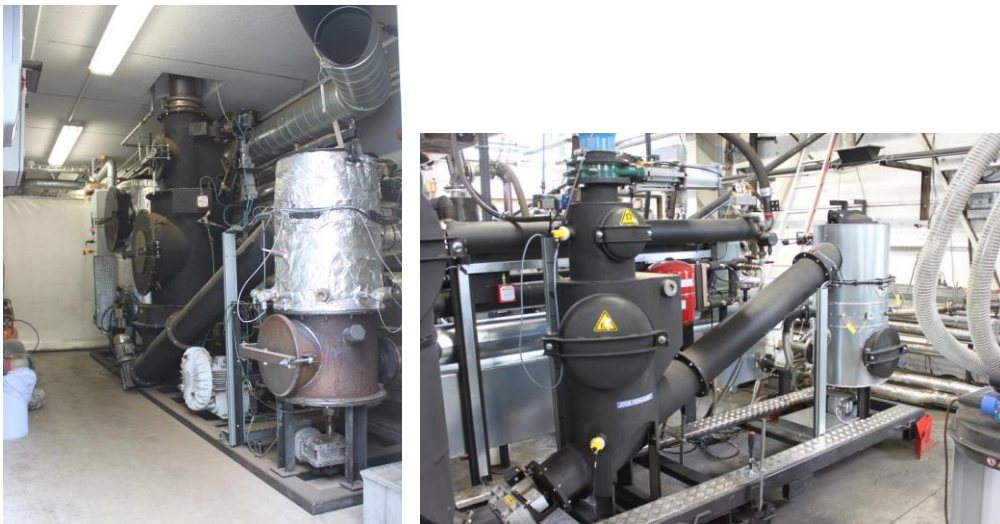
Photo 59: Gazéificateurs de petite échelle dans un container (gauche) et dans une usine (droite) de la compagnie « SpannerRE » (Source: Rutz D.)
