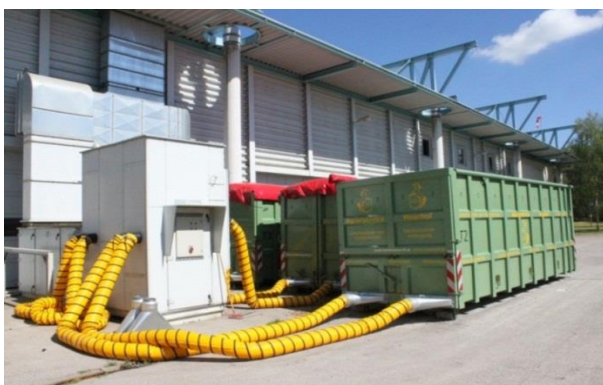
Abbildung 47: Container und Luftheizungsrohre zur Hackschnitzeltrocknung an einer Biogasanlage in München, Deutschland (Quelle: Rutz D.).
