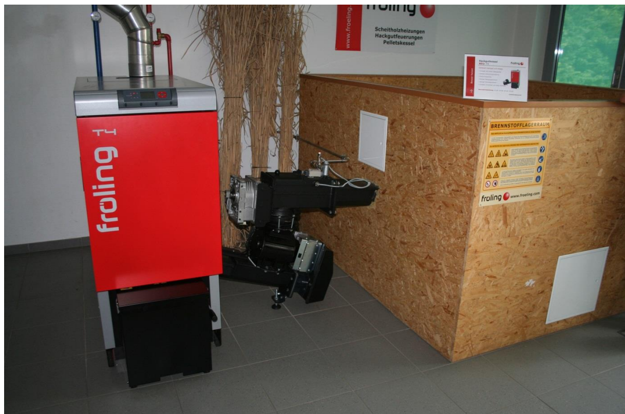
Abbildung 61: Kleines Hackschnitzelheizsystem (24-50 kW Heizkapazität) von der Firma Fröling mit dem Boiler (links), der Zuführeinrichtung (Mitte) und dem Hackschnitzelbunker (rechts) (Quelle: Rutz D.)
