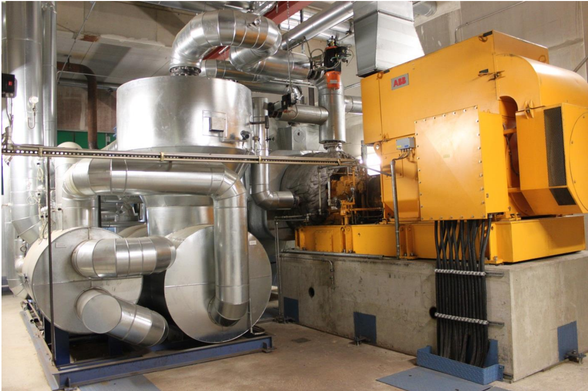
Abbildung 63: ORC-System (1.520 kW el ) der Grünfütterertrocknungsgenossenschaft Kirchdorf a.H. eG in Deutschland (Quelle: Rutz D.)
