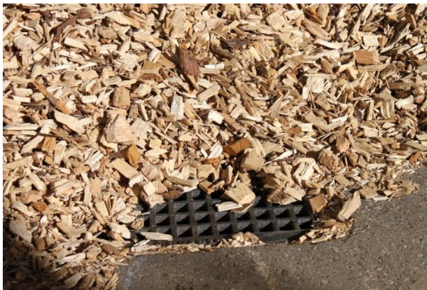
Abbildung 51: Ein in den Boden eingelassenes Lüftungsfenster in der Trocknungsanlage des Biomassehofs Achental, Deutschland (siehe Abbildung 52) (Quelle: Rutz D.).
