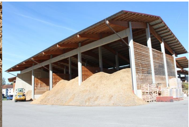
Abbildung 52: Ideale Hackschnitzel-lagerungs-einrichtung am Biomassehof Achental, Deutschland (Source: Rutz D.).
