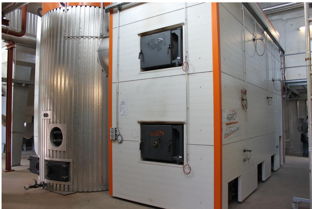
Abbildung 62: Mittelgroßes Hackschnitzelheizsystem (3.000 kW Kapazität) des Biomassehofes Achental in Deutschland mit dem Kessel (rechts) und dem Puffertank (links) (Quelle: Rutz D.)
