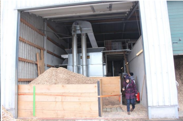
Abbildung 50: Schubwendetrockner für Hackschnitzel, installiert an einer Biogasanlage in Deutschland (Quelle: Rutz D.).
