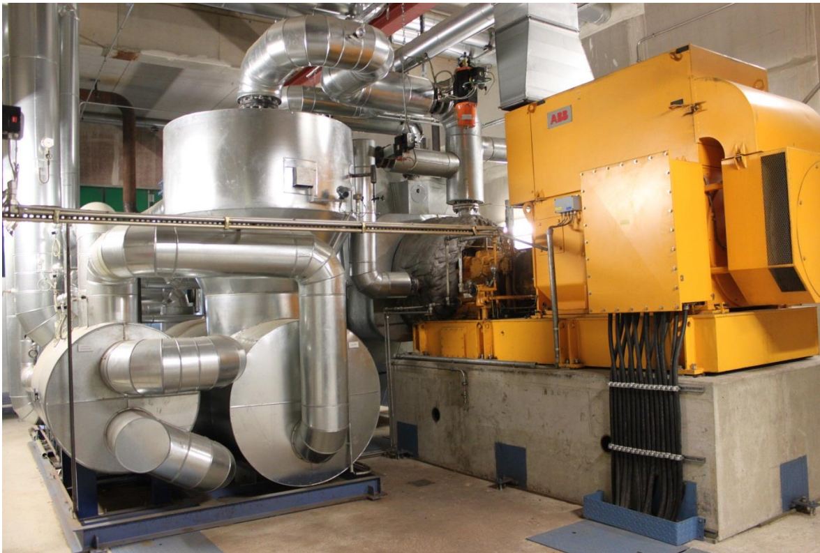
Εικόνα 64: Σύστημα ORC (1,520 kWel) της 'Grünfuttertrocknungsgenossenschaft Kirchdorf a.H. eG' στη Γερμανία (Πηγή: Rutz D.)
