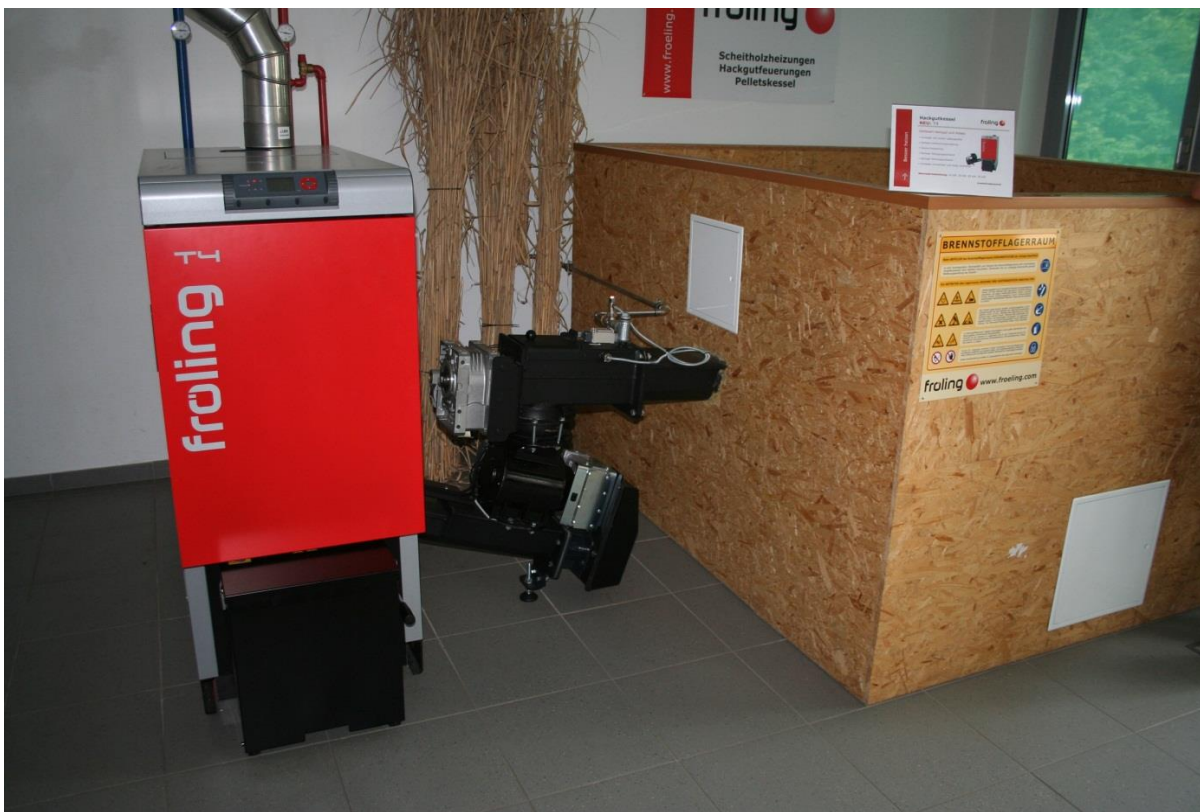
Εικόνα 62: Μικρό σύστημα θέρμανσης με θρυμματισμένο ξύλο της Fröling (24-50 kW εγκατεστημένης ισχύος) με το λέβητα (αριστερά), το σύστημα τροφοδοσίας (στη μέση) και τον αποθηκευτικό χώρο (Πηγή: Rutz D.)
