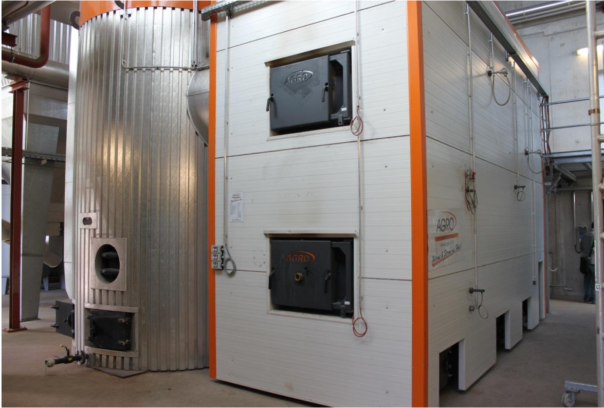
Εικόνα 63: Σύστημα θέρμανσης με θρυμματισμένο ξύλο μεσαίας κλίμακας (3,000 kW εγκατεστημένης ισχύος) του Κέντρου Βιομάζας του Achental στη Γερμανία, με το λέβητα (δεξιά) και το δοχείο αδράνειας (αριστερά) (Πηγή: Rutz D.)
