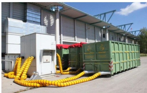
Εικόνα 48: Κιβώτιο μεταφοράς και σωλήνες θερμού αέρα για την ξήρανση θρυμματισμένου ξύλου σε μια μονάδα βιοαερίου στο Μόναχο, Γερμανία (Πηγή: Rutz D.)
