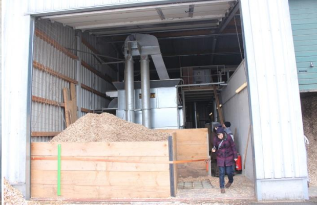
Εικόνα 51: Ξηραντήριο με αναμόχλευση για θρυμματισμένο ξύλο εγκατεστημένο σε μονάδα βιοαερίου στη Γερμανία (Πηγή: Rutz D.).
