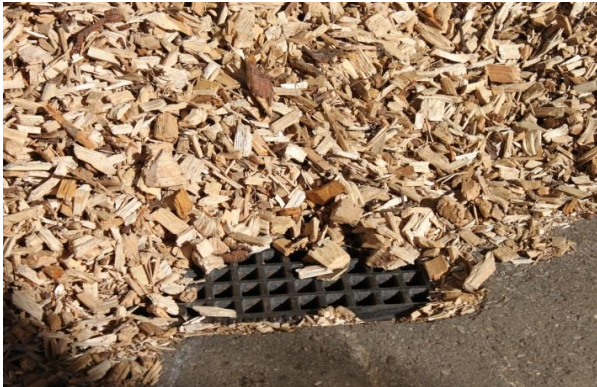
Εικόνα 52: Ενδοδαπέδια οπή αερισμού στις εγκαταστάσεις αποθήκευσης του Κέντρο Εμπορίου Βιομάζας του Achental, Γερμανία (Πηγή: Rutz D.).
