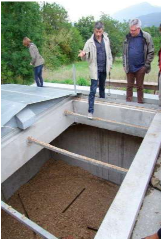
6.attēls: Šķeldas apkures sistēmas apskate (nodrošina apkuri pašvaldības ēkām, bibliotēkai un 3 pašvaldības dzīvokļiem) Le Percy
