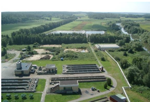
20. attēls: Kārkļu stādījumi centrālajā Zviedrijā (fonā), kas tiek apūdeņoti ar notekūdeņiem no vietējām attīrīšanas iekārtām (Foto: Pär Aronsson)
