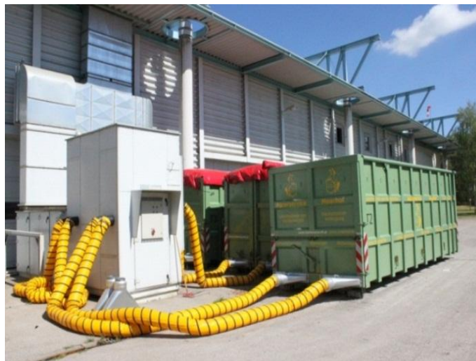
Контејнер со цевки за топол воздух во централа за биогаз
