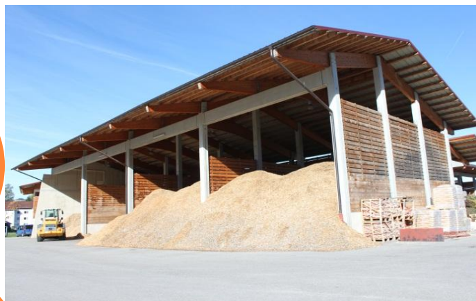
Идеален објект за складирање на дрвен чипс
