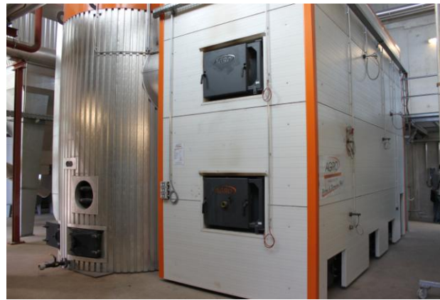
Средна големина на систем за греење со дрвен чипс (3,000 kW греен капацитет) со котел (десно) и резервоар (лево)
