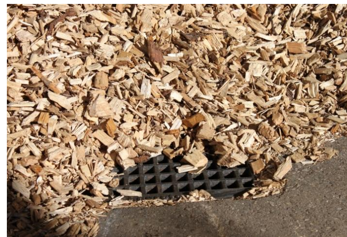
Вентилација во подот на објектот за складирање
